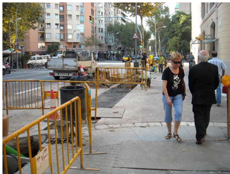
Treballs efectuant-se en el carrer de les Flors
